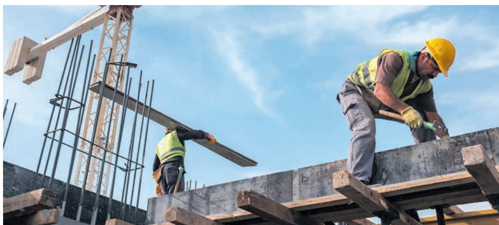
Sur les chantiers, le travail au noir pénalise travailleurs et employeurs honnêtes. Photo: Adobe Stock
